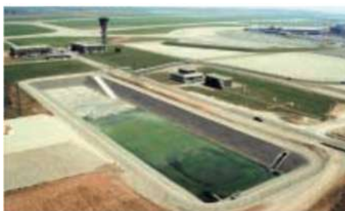
Figure.IV.6: Exemple d'un Bassin de décantation sur aéroport
