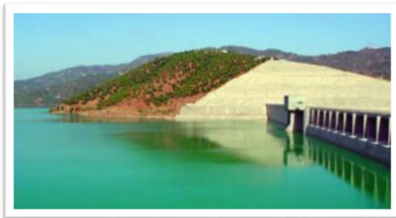
Figure 1.1 :Barrage en BCR de koudiat acerdoune wilaya de Bouira en Algérie
