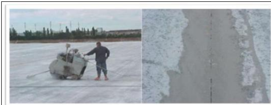
Figure1.11 :Exécutiondejointsparsciageaprès mise en placeduBCR-aireIndustriel-Montréal[11].
