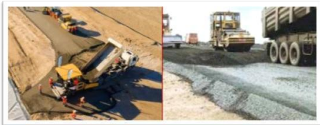
Figure 1.3 : Production, de déchargement, de mise en place et de compactage du BCR.
