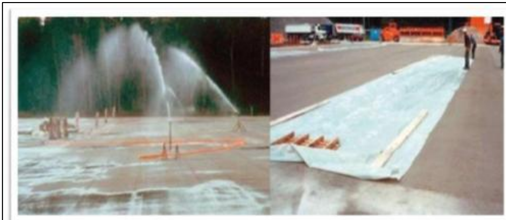
Figure1.10 : (a)Cure du béton par arrosages ciblés , (b) Bâche de protection contre la pluie [15].
