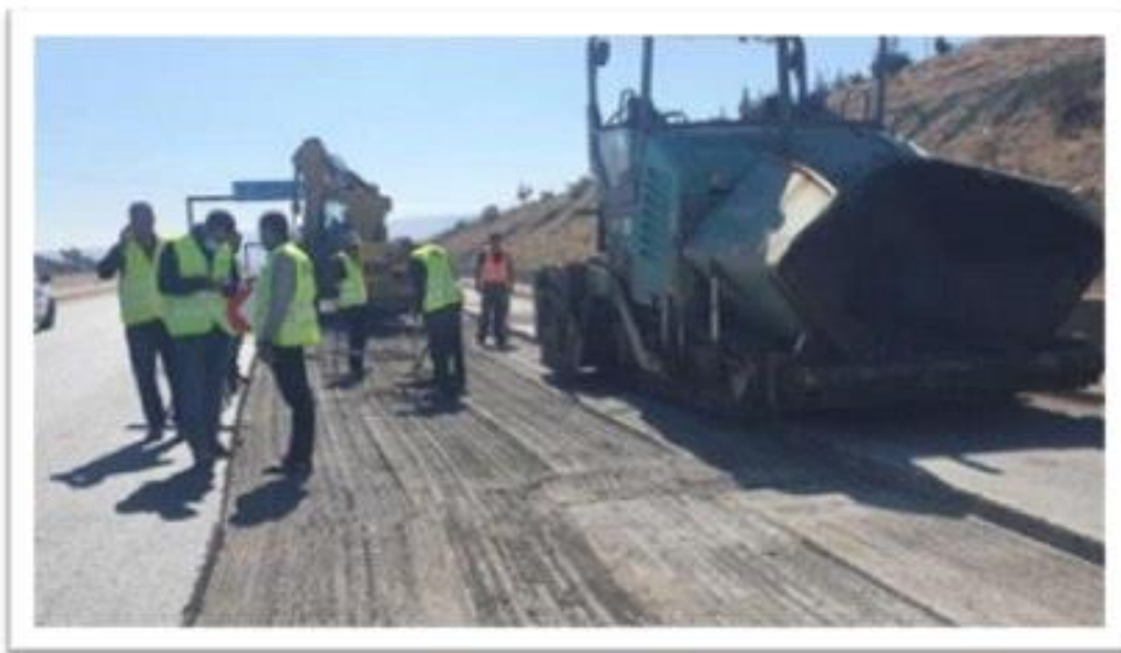
Figure 2.6 : Travaux de fraisage sur la RN5 : Bouira [58]
