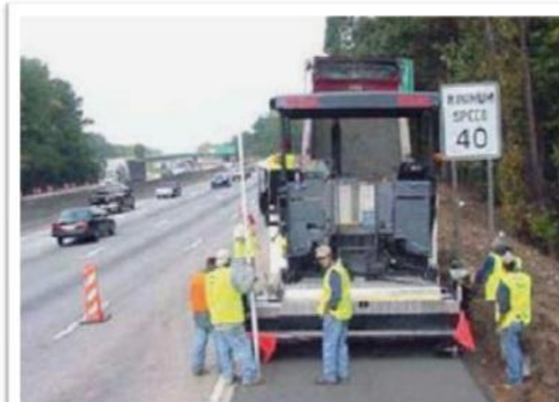
Figure 1.14 : Mise en place du BCR en pavage - Atlanta USA [3].
