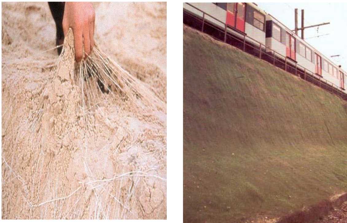
Figure (5.6) Soutènement en Teksol
