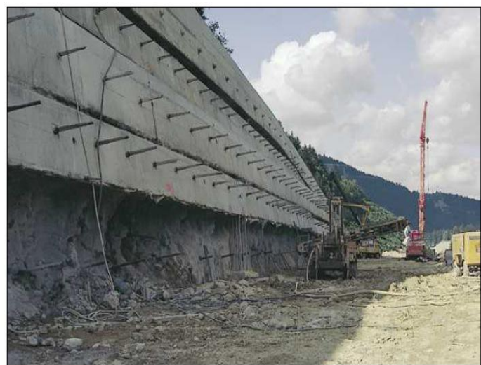
Figure (5.12) Voiles de soutènement ancrés (Epinglé)
