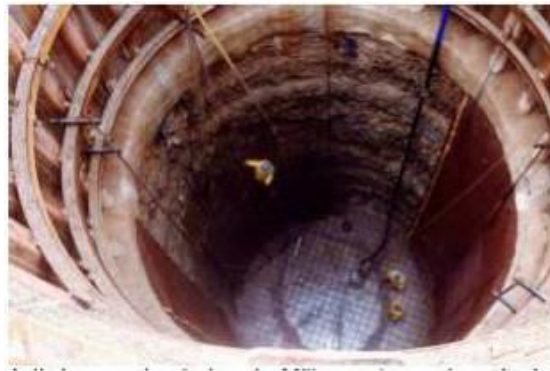
Figure (4.9) Puits avant mise en place des armatures.
