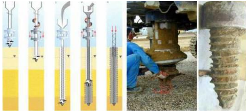
Figure (4.12) Pieu vissé de type Oméga à deux pas de vis ou un seul.
