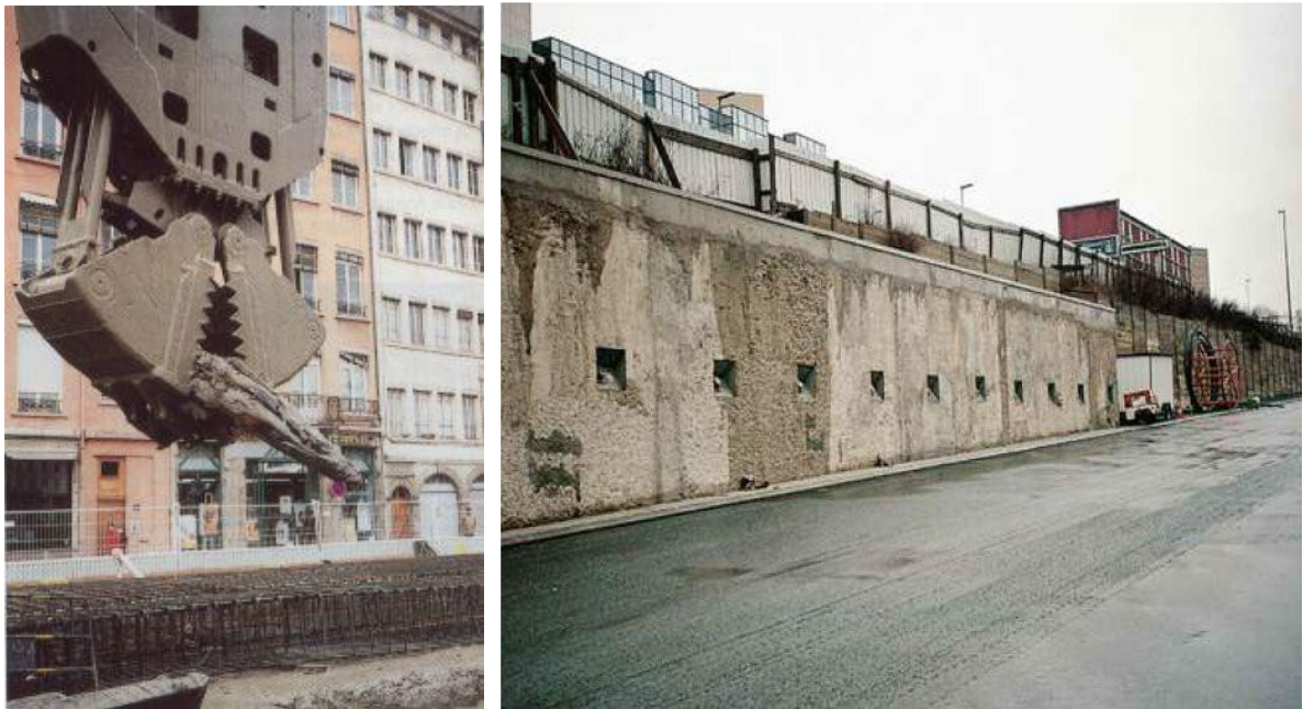
Figure (5.9) Exemple de paroi achevée, avec tirants
