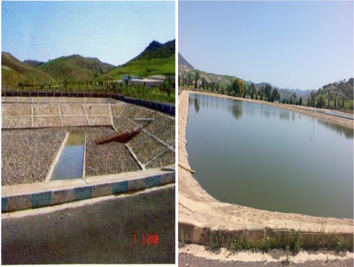
Figure 24 : Bassin décantation (avant et après l'utilisation).
