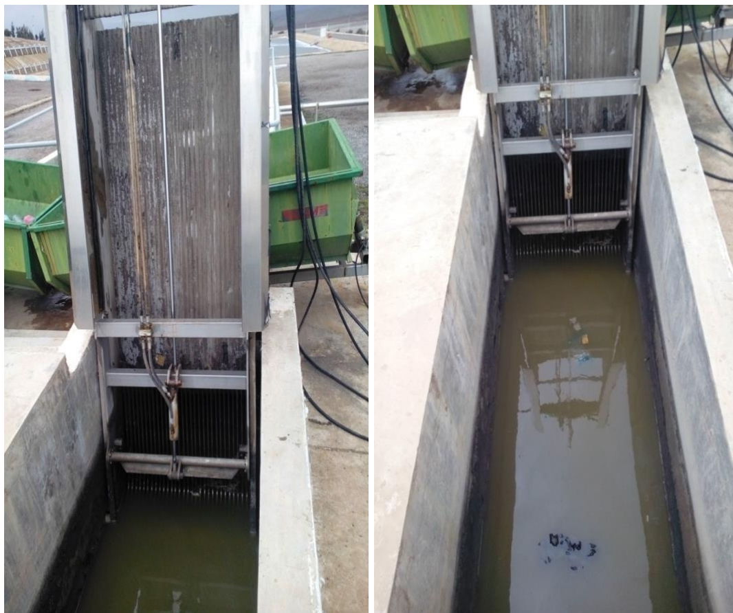
Figure 18 : Ouvrage de Degrilleur.
