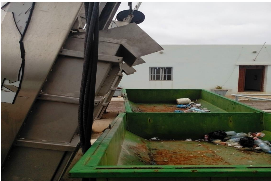
Figure 19 : Ouvrage de Degrilleur.
