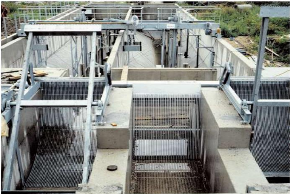
Figure 02: Prétraitement- Dégrilleur.
