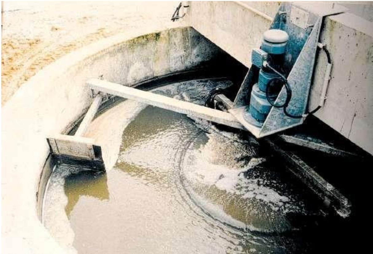
Figure 07: Prétraitements – Dégraisseurs.
