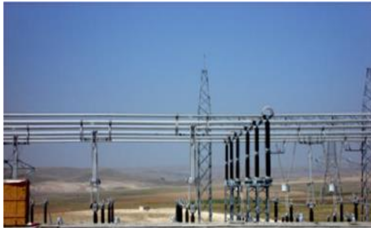
Figure I.12: Jeux de barres
