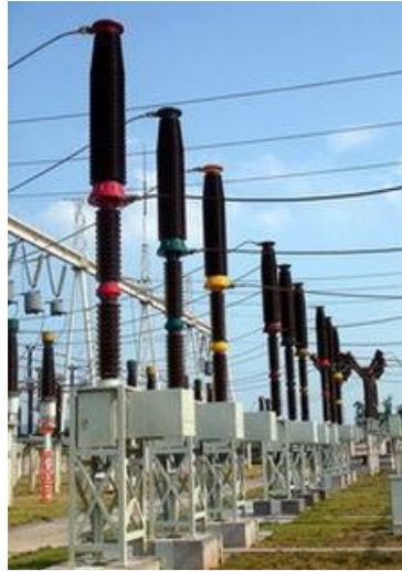
Figure I.10: Disjoncteur
