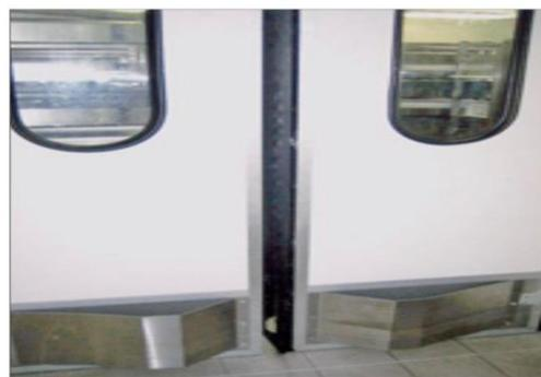
**Figure N°04 : Porte en profile en aile d'avion.**
