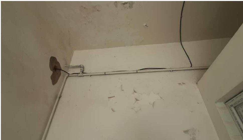
**Figure12** : Faillances cassé ou humidité et fissures sur les murs au niveau de restauration(Ecole primaire Bachir EL IBRAHIMI).
