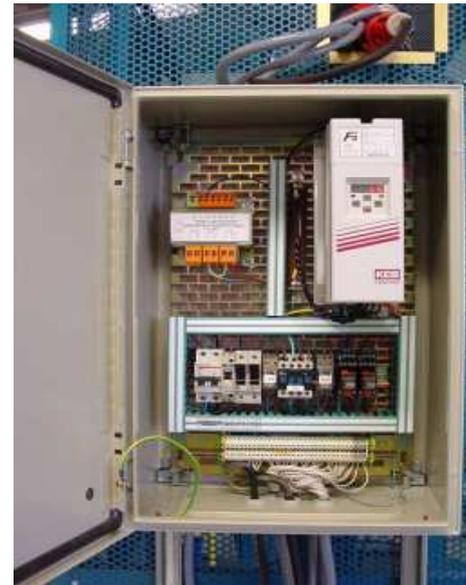
Figure I-4. Armoire de manœuvre
