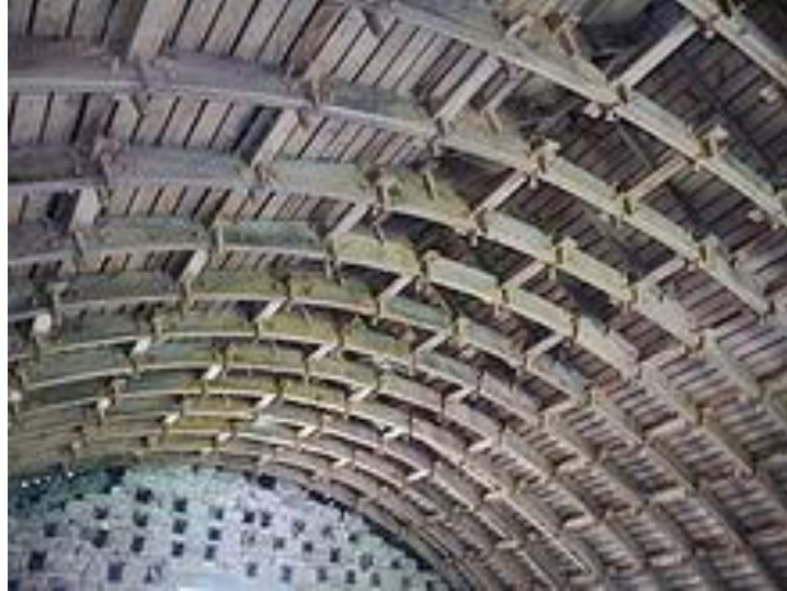
Figure V.3 : Charpente en lamellé-collé au château de Courceriers (Mayenne).
