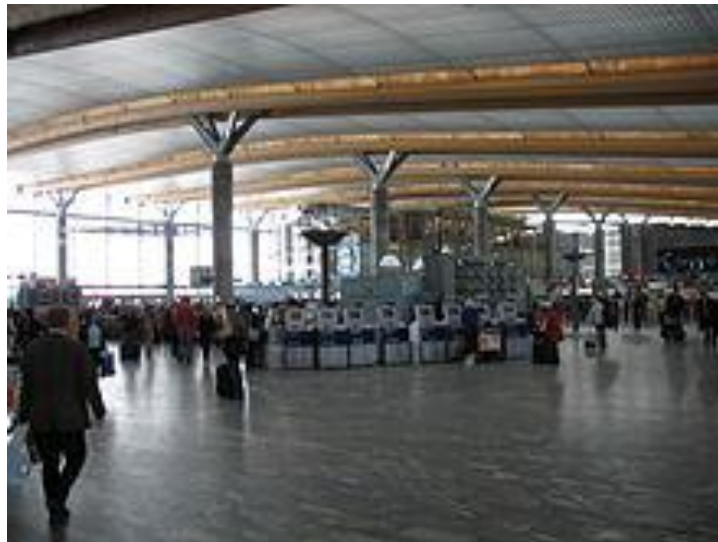
Figure V.2 : Poutres en lamellé-collé de l'aéroport d'Oslo.
