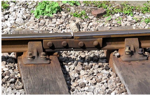
Figure 3.2 : Utilisation des aciers
