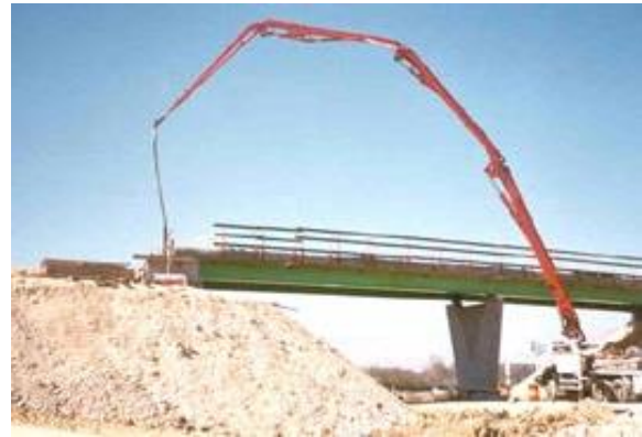
Figure 14 : Pompage du béton
