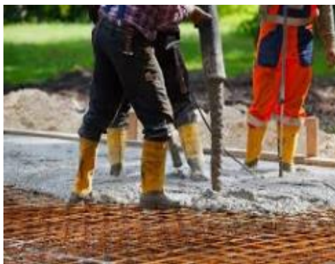
Figure 15 : Mise en place du béton
