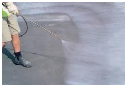
Figure 16 : La cure du béton
