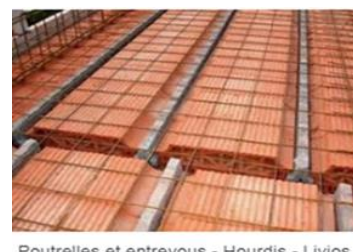
Fig. 2.3 : Hourdis pour planchers
