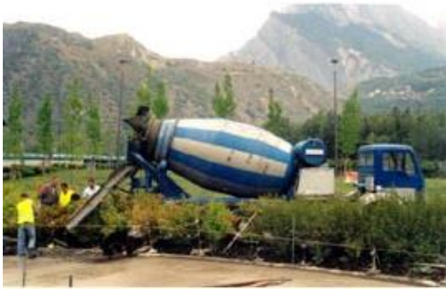
Figure 13 : Mise en place du béton à la goulotte
