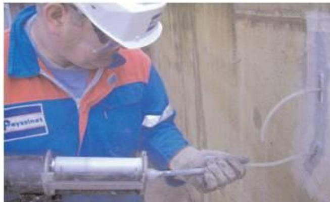
**Figure II.4** : Pistolet manuel d'injection [5]
