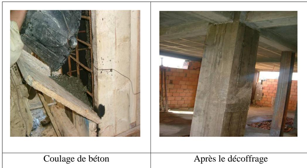
**Figure 7.2 :** Réparation d'un poteau par augmentation de section. [2]
