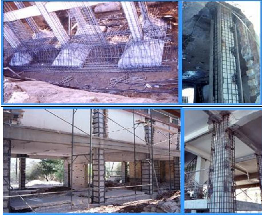
**Figure 7.1** : Disposition des armatures pour chemisage des fondations et des poteaux [1].
