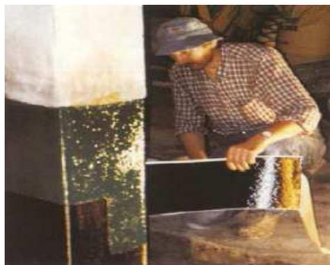
**Figure.II.16 :** polymère renforcé de fibre (PRF) appliqué in-situ.
