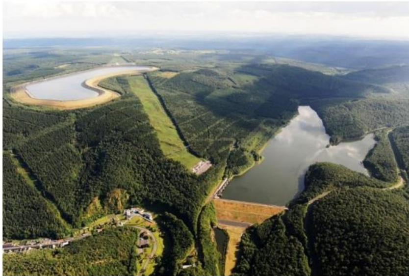
Figure (5.3) : La STEP de Revin dans les Ardennes, réservoirs de 7 millions de m 3 , dénivelé 230m (puissance jusqu'à 800 MWh),
