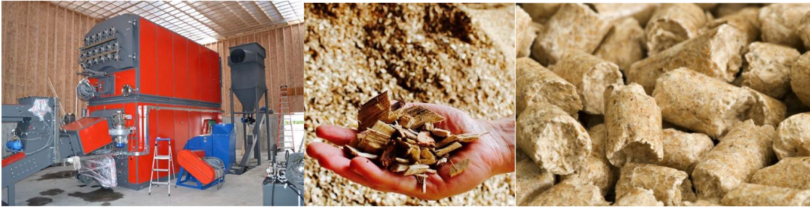
Figure (4.8) : Une chaudière (a), des plaquettes (b) et des granules (c)
