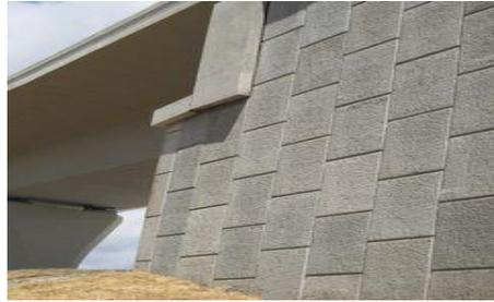
Le mur caissons est le plus résistant. Il est constitué d'un ensemble de boîtes alignées, superposées, ou encore alignées et superposées. La stabilité du mur est assurée par la largeur des caissons et le poids du matériau de remplissage.
