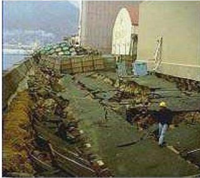
**Fig V.3.** Inclinaison des murs de soutènement
