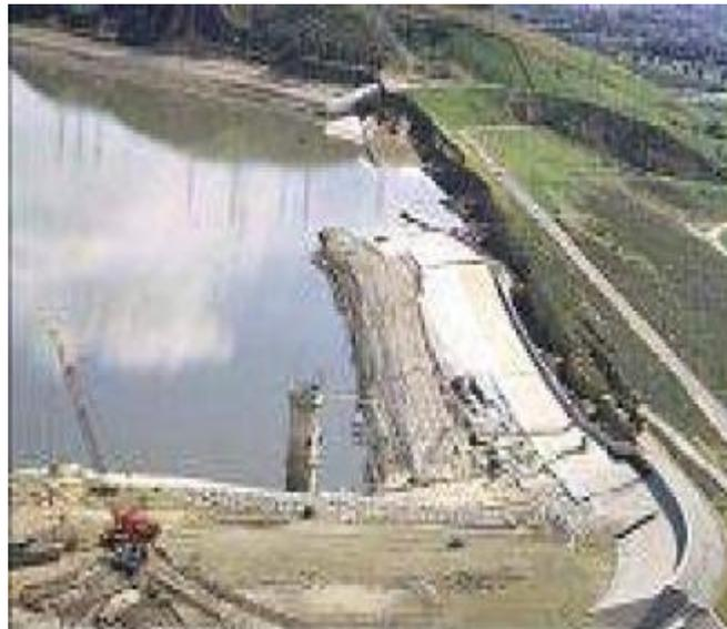
**Fig V.4.** Effondrement du parement amont du barrage de San Fernando pendant Le séisme de 1971.
